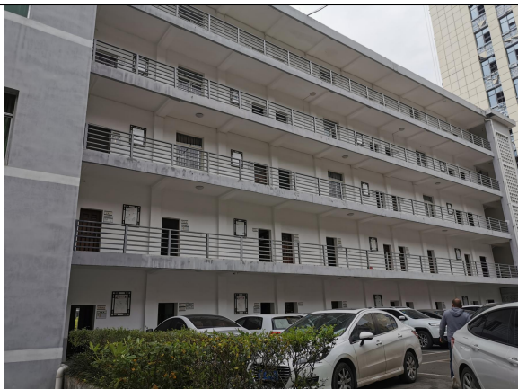
现行政办公楼（拟拆除进行本次改扩建项目）
