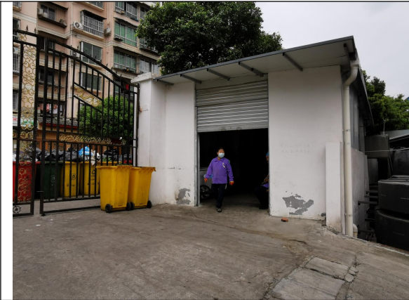
生活垃圾暂存间
