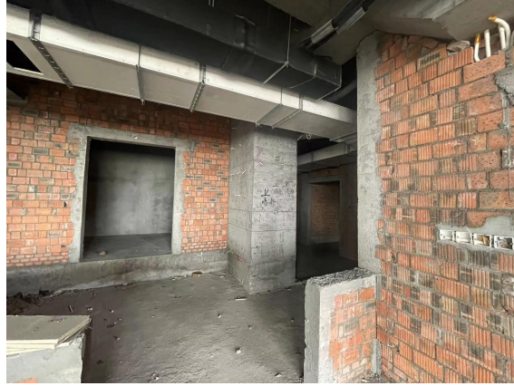
门诊住院综合楼六楼现状
